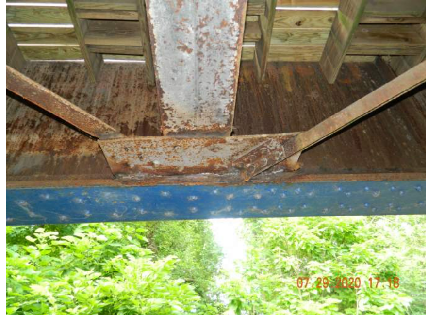
TYP. BENT GUSSET PLATE
