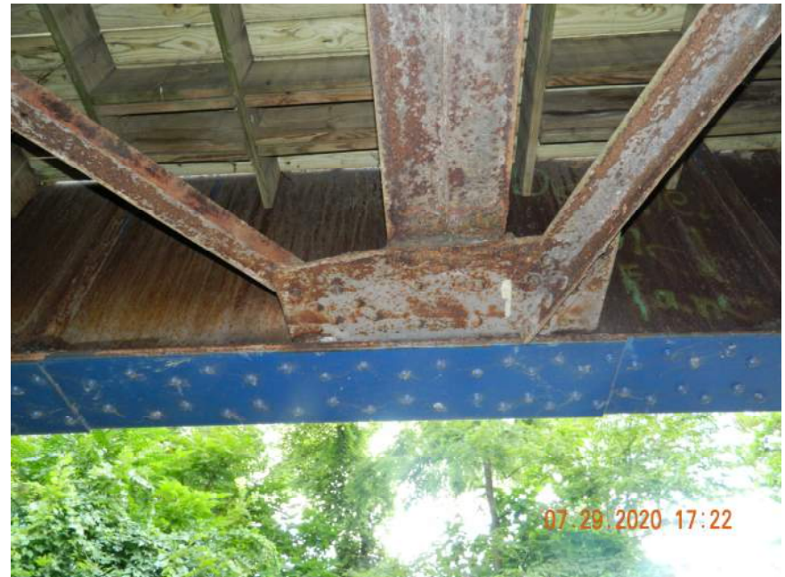
TYP. BENT GUSSET PLATE
